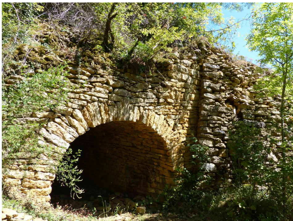
Fig. 1 : Entrée d'un tunnel du Mont d'Or.
